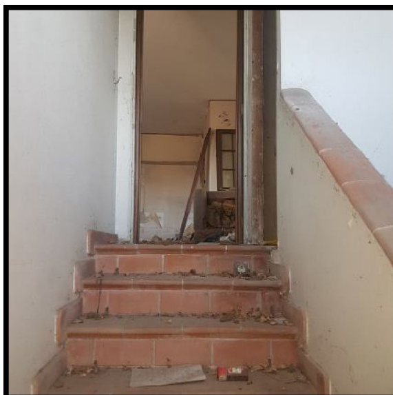
Foto 15 Interni scala di accesso al piano primo.JPG
